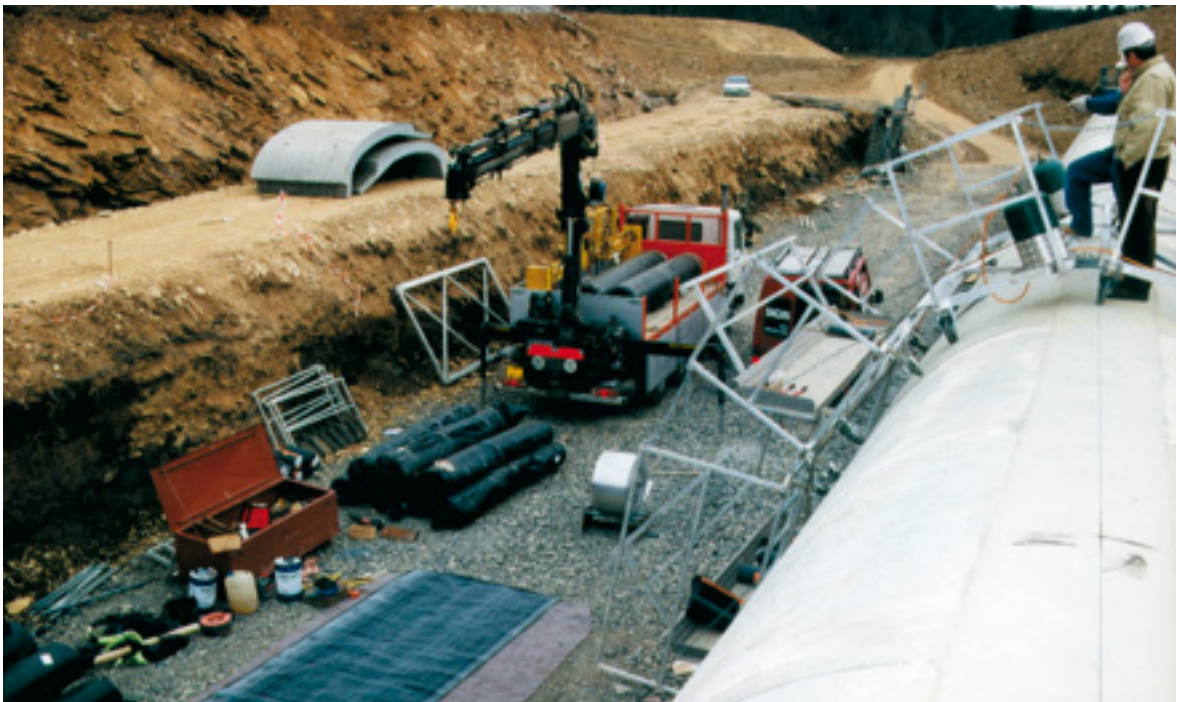
Etanchéité d'ouvrage d'art voûté. Les feutres bitumeux sont manipulés à la grue auxiliaire et déroulés sans effort sur l'ouvrage.
